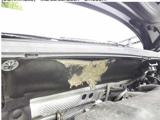
Beschädigung #3: Karosserie: Stirnwandverkleidung (Dämmmatte) - Marderschaden - erneuern
