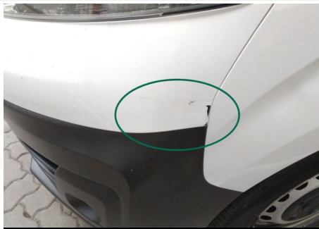
Stoßfänger oberhalb / Vorne / Kratzer
