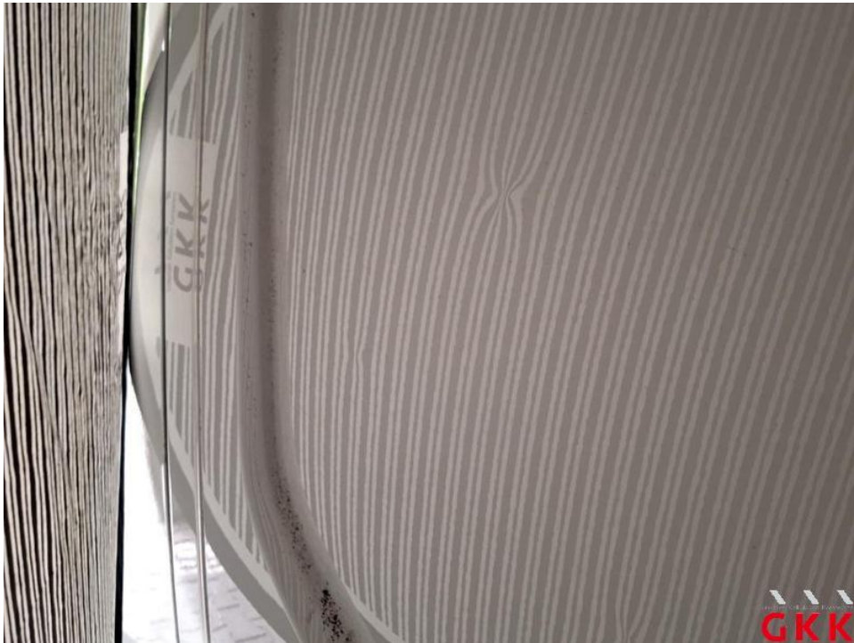
Bild 40. Seitenwand links, vorne, beschädigt, instand setzen - lackieren
