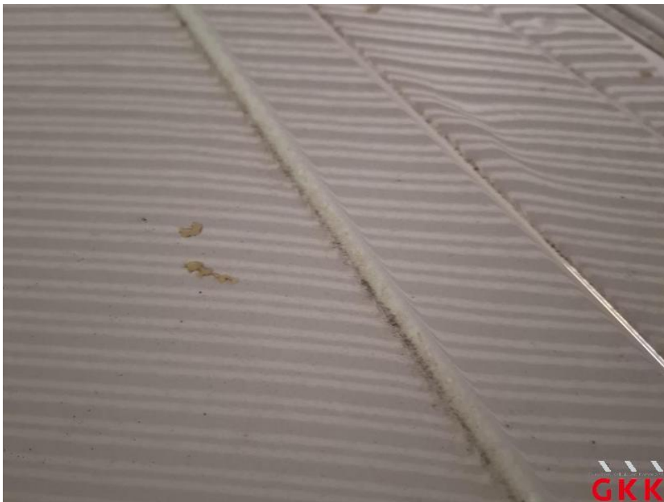
Bild 42. Dach, bis 3 Dellen / Bauteil, kalt drücken
