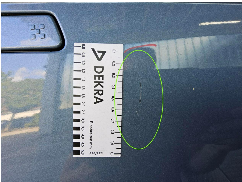
Bild 8 : Tür hinten rechts Lackierung, verschrammt, lackieren mit Lackaufbau
