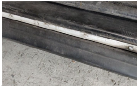
Türdichtung / Vorne Links / Fehlt
