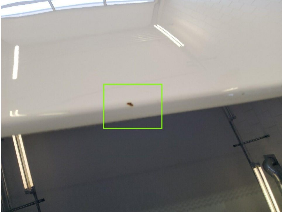
Bild 19 : Steinschlag an der Dachkante
