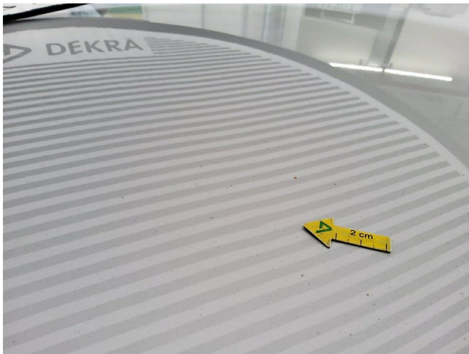
Bild 13 : Dach, eingedellt, Gebrauchsspur
