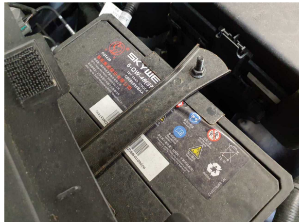
Beschädigung #7: elektrisches System: Batterie - elektrischer Fehler - befunden ggf. instandsetzen
