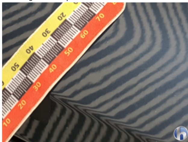
5. Seitenwand - Hinten - Links 2 Dellen - Sanft Instandsetzen
