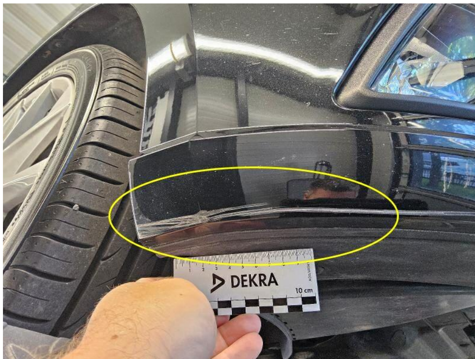
Bild 25 : Stoßfänger vorne verformt und verschrammt mit Materialabtrag
