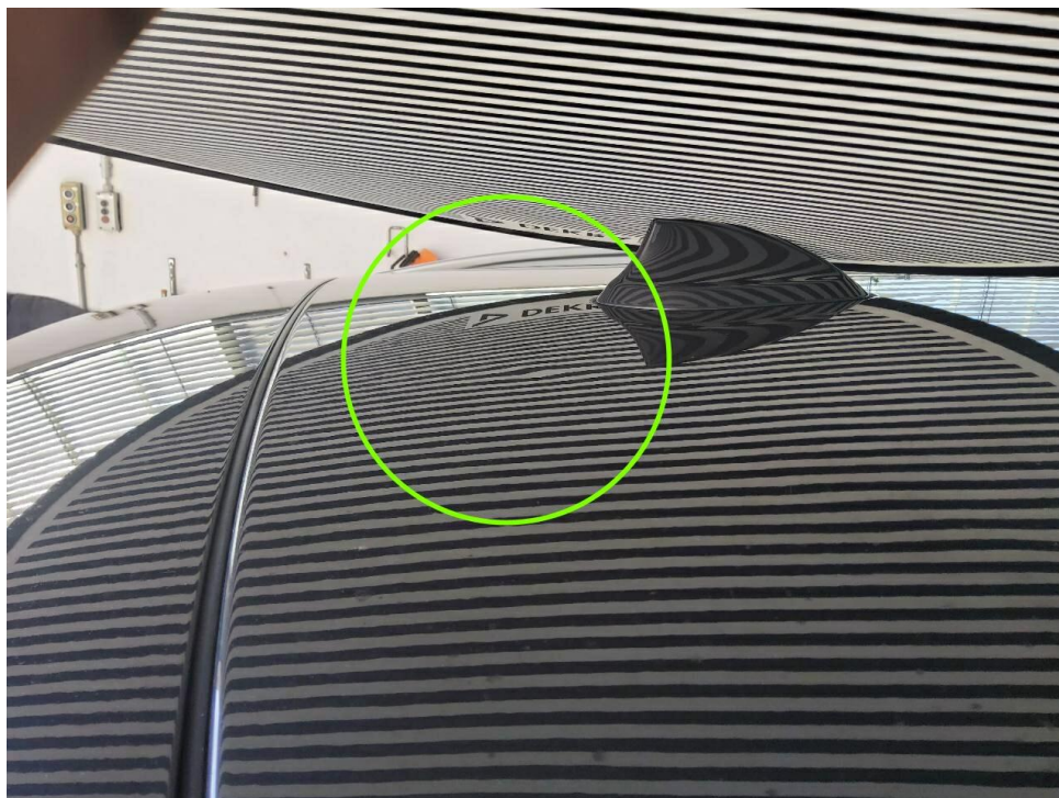
Bild 10 : Dach, eingedellt, Gebrauchsspur
