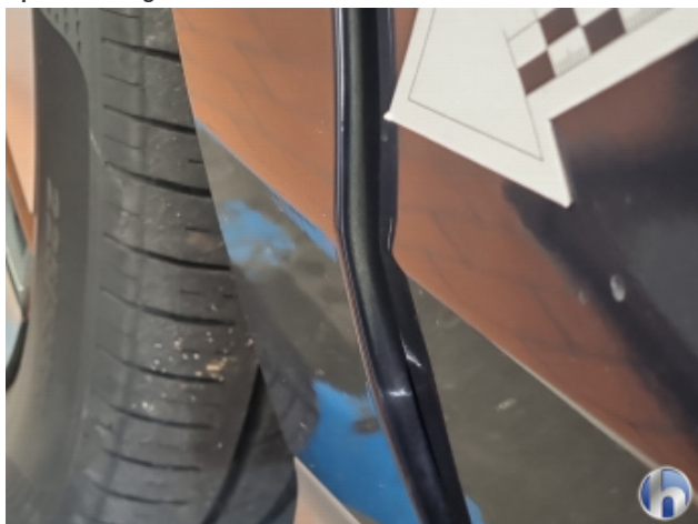
2. Kotflügel Vorne - Links Spaltmaß Ungenau - Nacharbeiten
