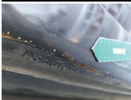
Schweller / Links / Rost
