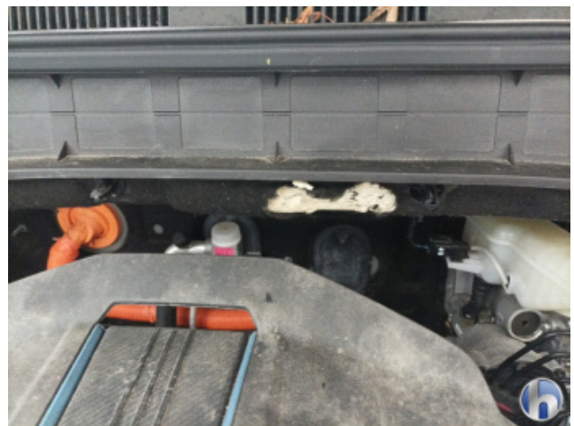
3. Motor Marderbiss /-schaden - Erneuern
