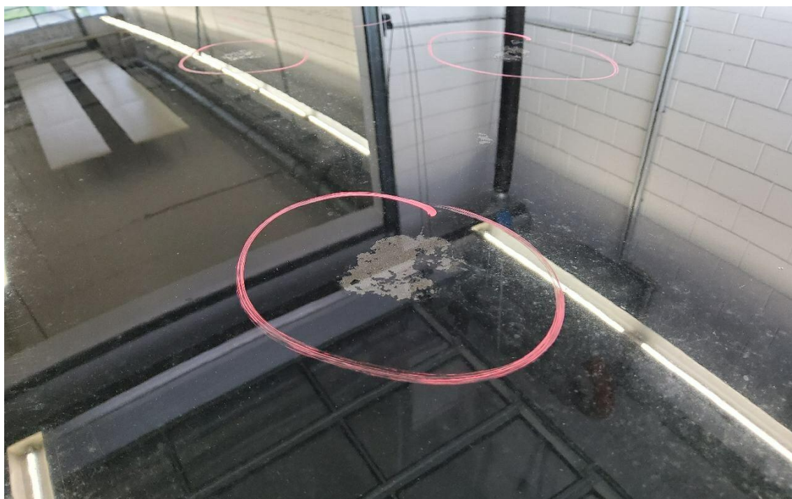
Bild 14 : Dach Lackverätzungen
