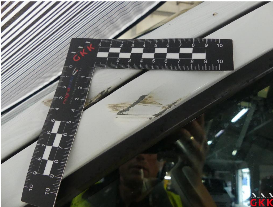
Bild 18 Tür vorne links, beschädigt, ersetzen
