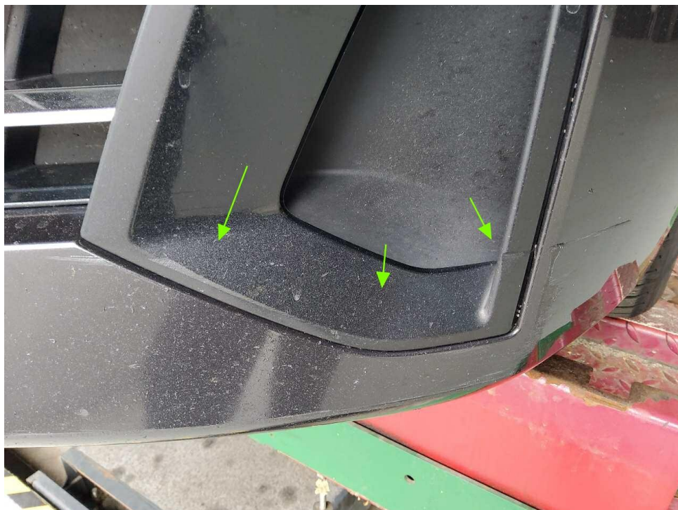
Bild 32 : Blende Stoßfänger VL verschrammt (Verbundarbeit)
