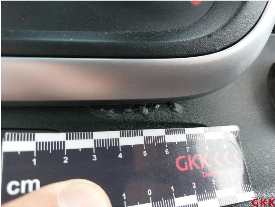
Bild 35. Armaturenbrett, Blende, beschädigt, ersetzen
