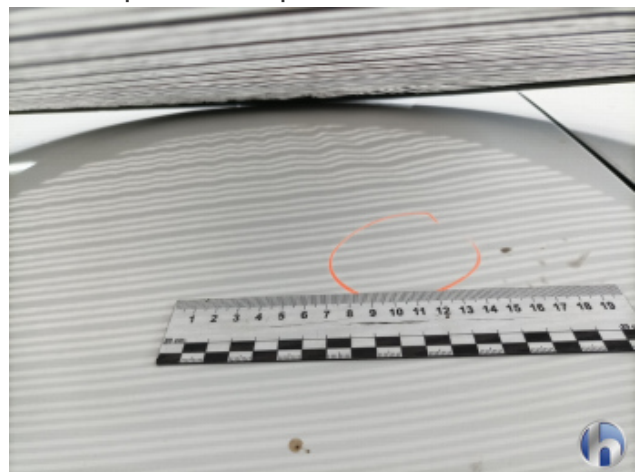
6. Dach Gebrauchsspuren - Ohne Reparatur
