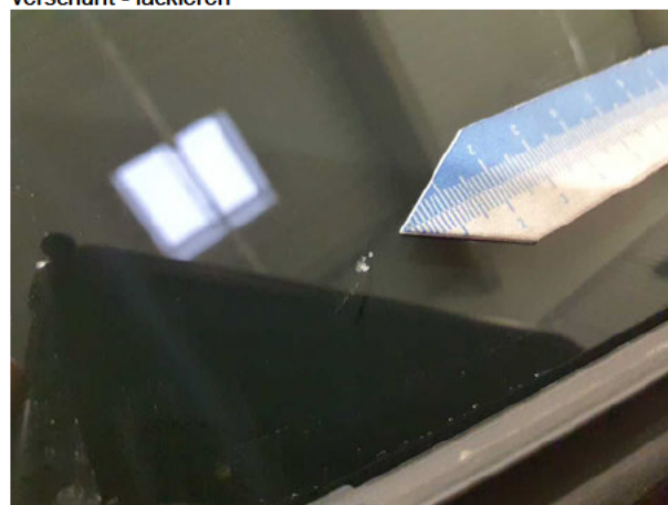
Beschädigung #8: Verglasung: Frontscheibe - gebrochen / gerissen - erneuern
