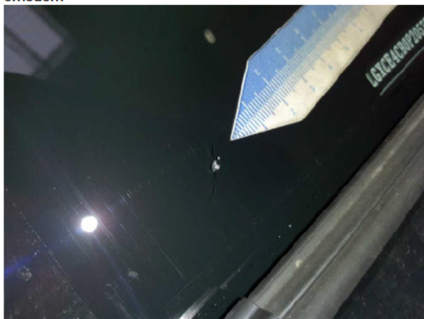
Beschädigung #8: Verglasung: Frontscheibe - gebrochen / gerissen - erneuern
