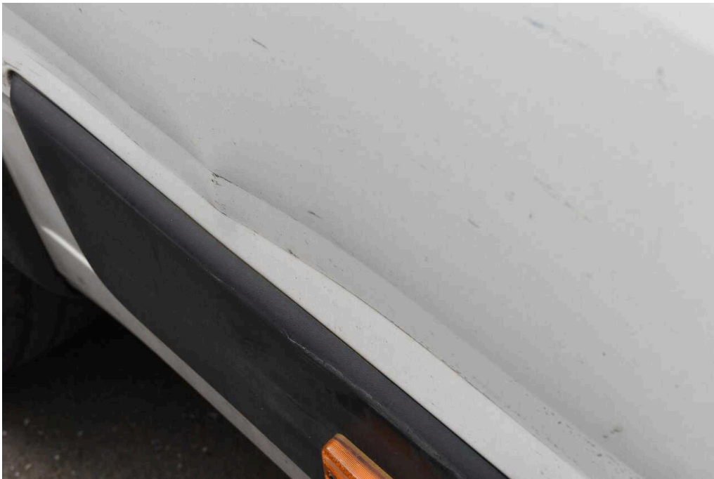
Bild 65 Fahrzeugheck Ecksäule hinten rechts deformiert, instandsetzen+lackieren, Seitenwand hi. re. deformiert, instandsetzen+lackieren, Schiebetüre re. deformiert, erneuern+lackieren
