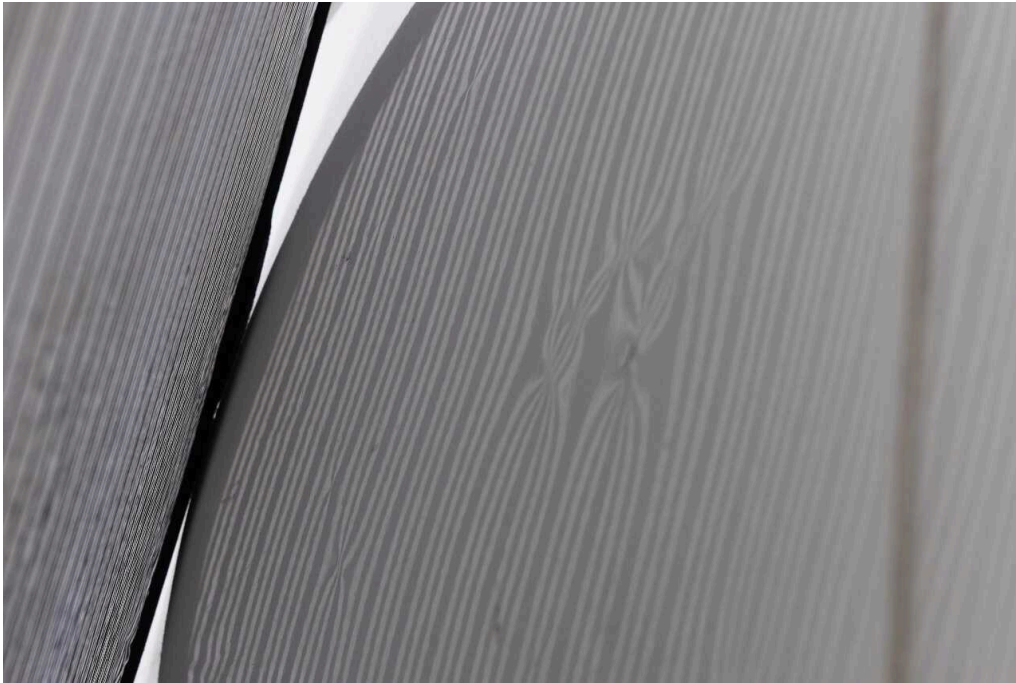
Bild 41 linke Seite Seitenwand hinten links deformiert
