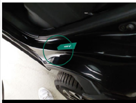
Türeinstieg / Hinten Links / Delle
