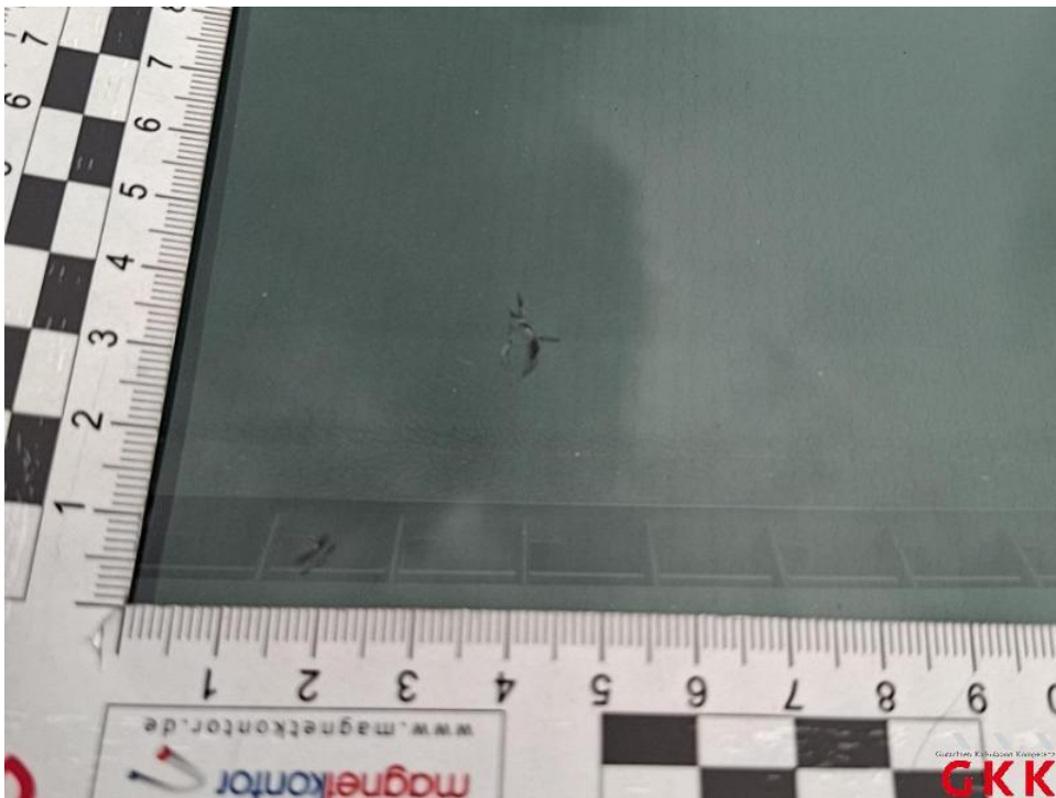
Bild 16. Frontscheibe, beheizt mit Regensensor und Frontkamera, Steinschlag mit Rissbildung, ersetzen
