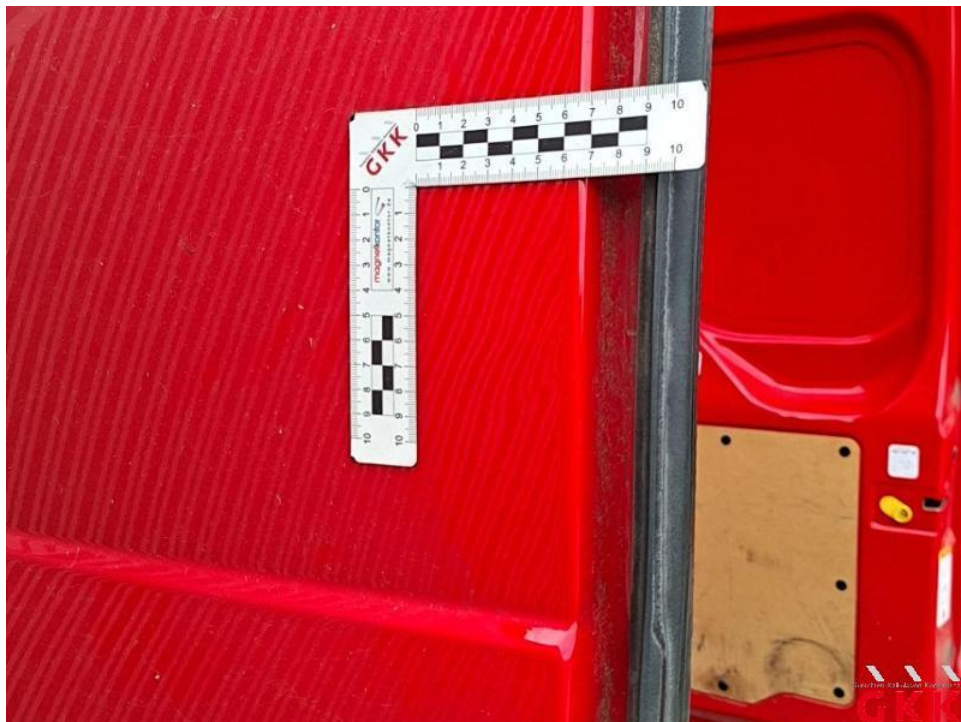
Bild 50. Hecktür links, beschädigt, instand setzen - lackieren
