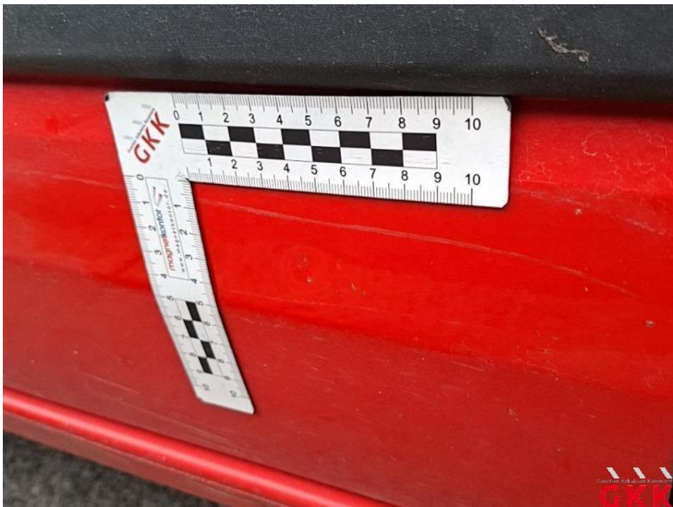
Bild 32. Schiebetür rechts, unterhalb, beschädigt, instand setzen - lackieren
