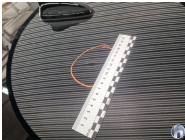
5. Dach Delle - Sanft Instandsetzen
