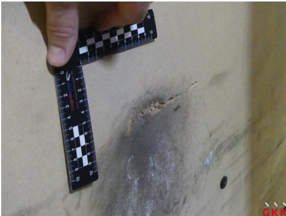
Bild 16 Schiebetür rechts, Innenverkleidung -Abdeckung-, beschädigt, ersetzen
