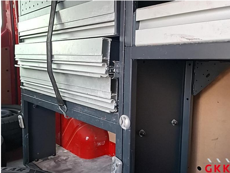
Bild 37. Laderaum, Regalsystem, beschädigt, instand setzen
