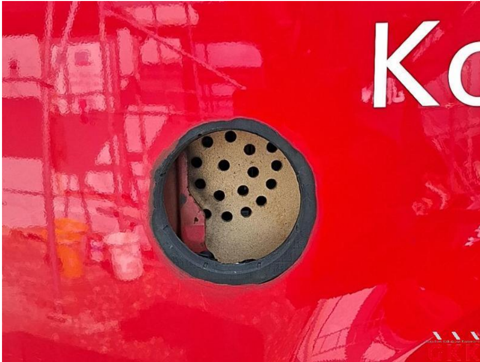
Bild 29. Seitenwand rechts, Be-/Entlüftungselement, fehlt, ersetzen
