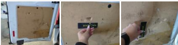
Boot door lining R, Broken, Replace
