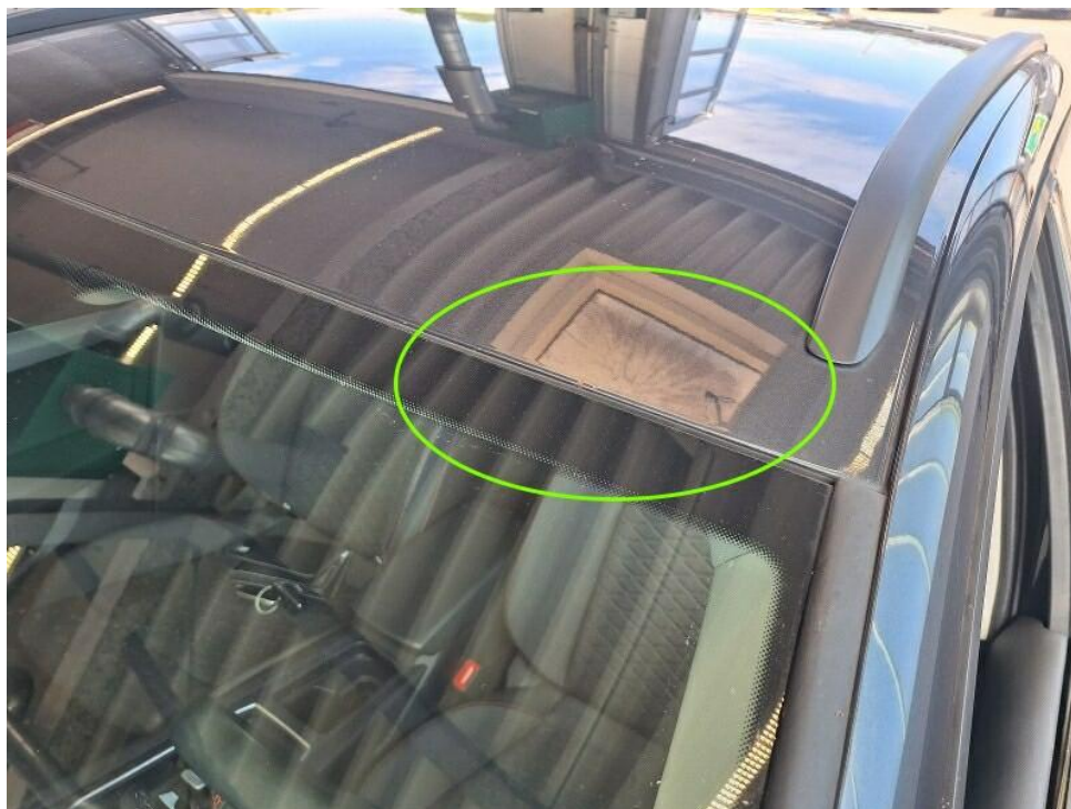
Bild 15 : Dachkante vorne Steinschlagabplatzungen mit Rostbildung
