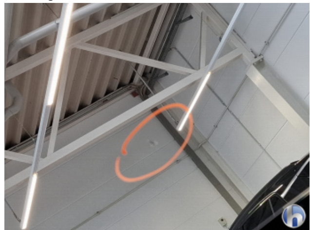
12. Windschutzscheibe Beschädigt - Erneuern
