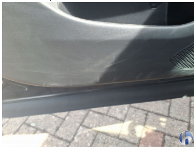
10. Verkleidung Gebrauchsspuren - Ohne Reparatur
