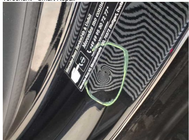
Beschädigung #3: Schweller links: Einstieg - Delle(n) - sanft instandsetzen
