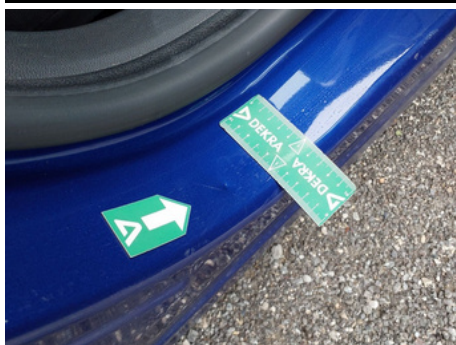
Entrée de porte / Avant Droit / Enfoncement
