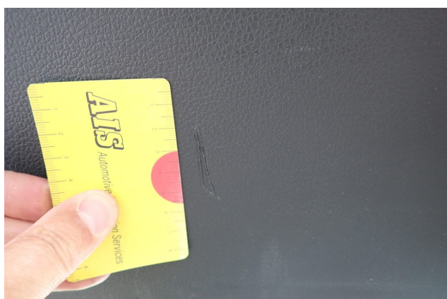
Beschädigung 2: Verkleidungen/Abdeckungen: Heckdeckel, Innenverkleidung - verkratzt / verschürft - Smart Repair
