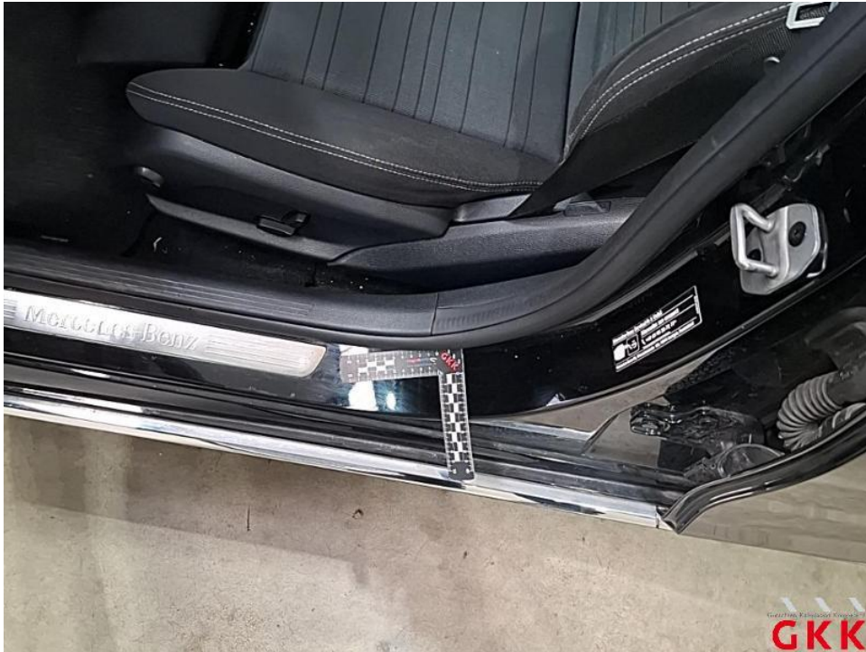
Bild 27. Tür vorne links, Einstieg, beschädigt, instand setzen - lackieren
