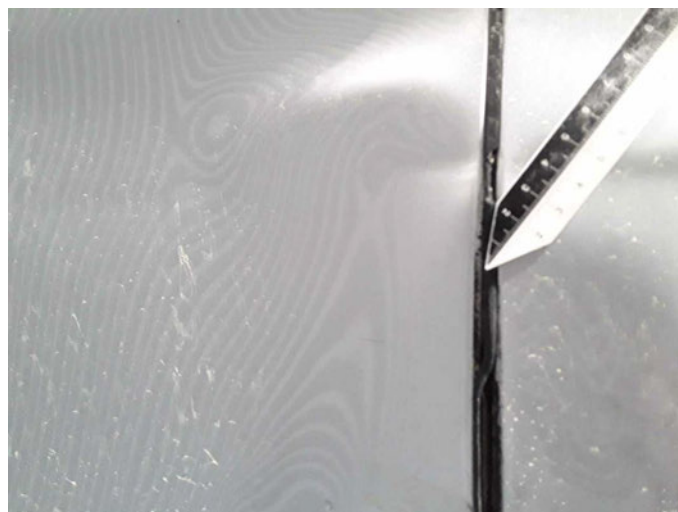
Beschädigung 15: Seitenwand links: Seitenwand - verformt - erneuern
