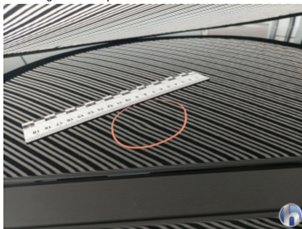
6. Dach Delle - Sanft Instandsetzen
