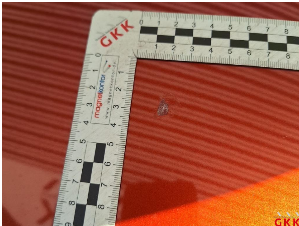
Bild 25 Dach, Lackierung verätzt, aufbereiten
