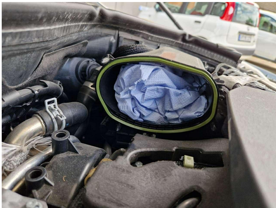
Bild 25 : Abgasturbolader lt. KV defekt Abgasturbolader lt. KV defekt
