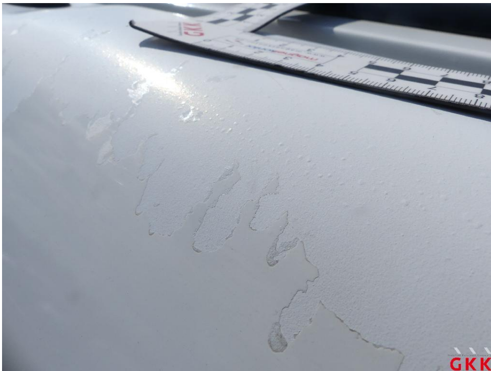
Bild 28. Seitenwand links, Lackierung abgeplatzt, lackieren
