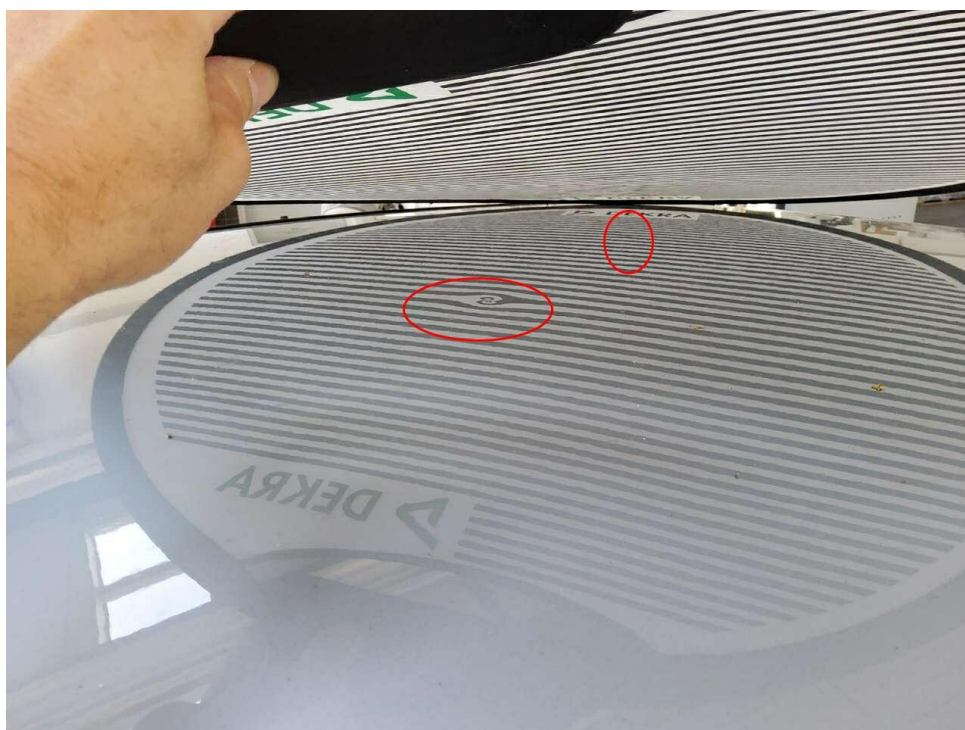
Bild 38 : Dach, mehrfach eingedellt, drücken
