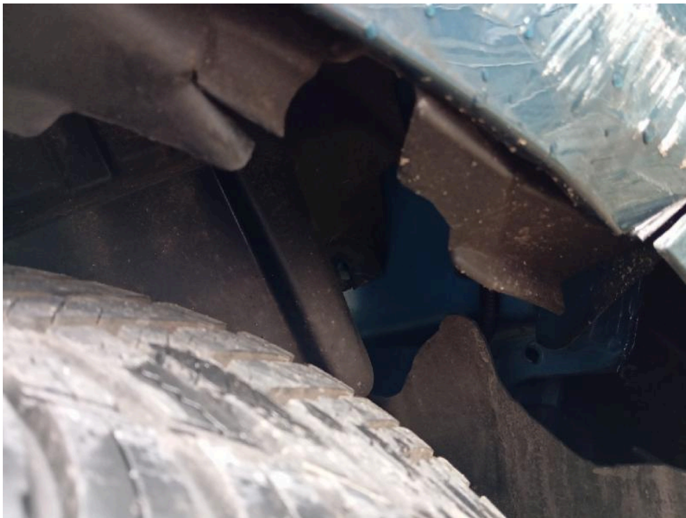
Bild: 15 Radhausschale hinten links gebrochen
