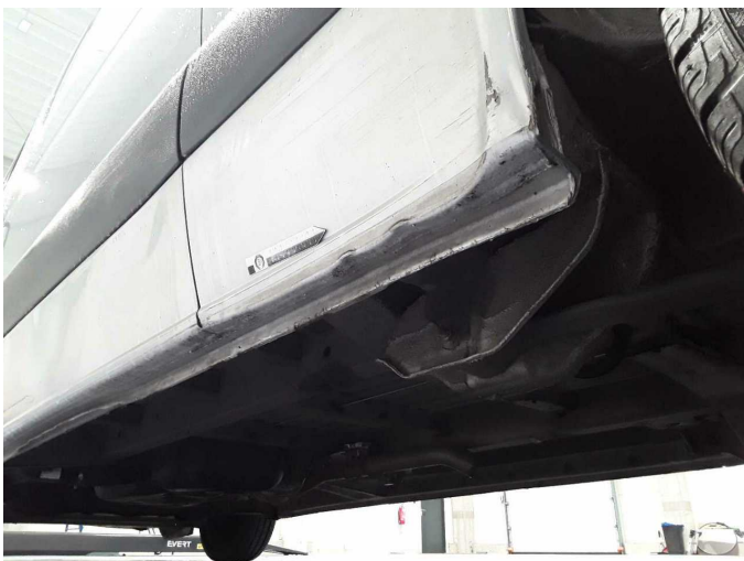
Beschädigung 8: Schweller links: Schweller - beschädigt - erneuern
