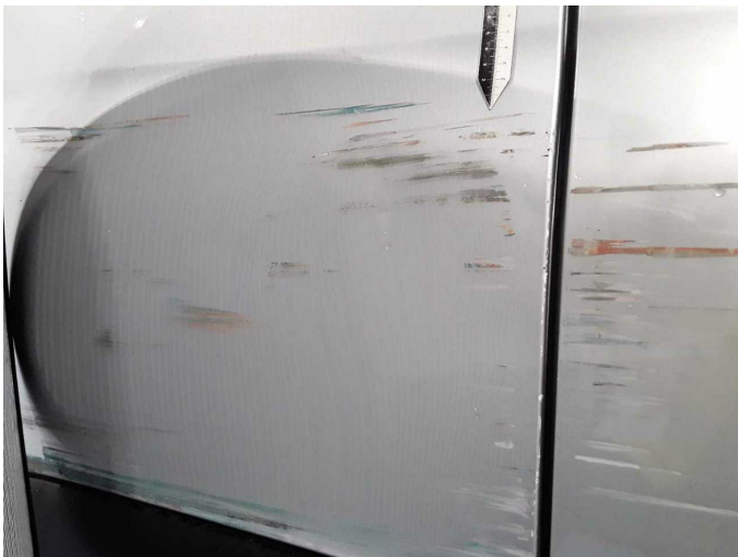
Beschädigung 30: Seitenwand rechts: Seitenwand - beschädigt - erneuern
