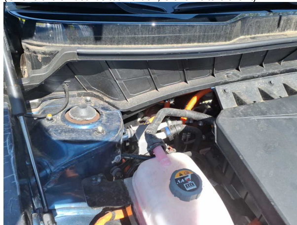
Beschädigung #6: Fahrerhaus: Dämmmatte - Marderschaden - erneuern
