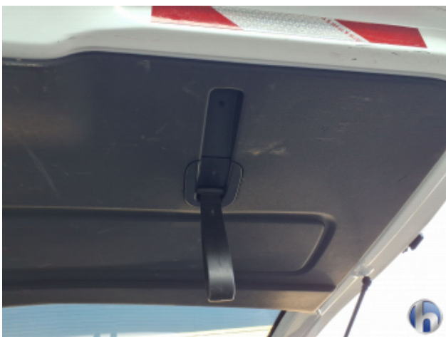
8. Heckklappenverkleidung Beschädigt - Erneuern
