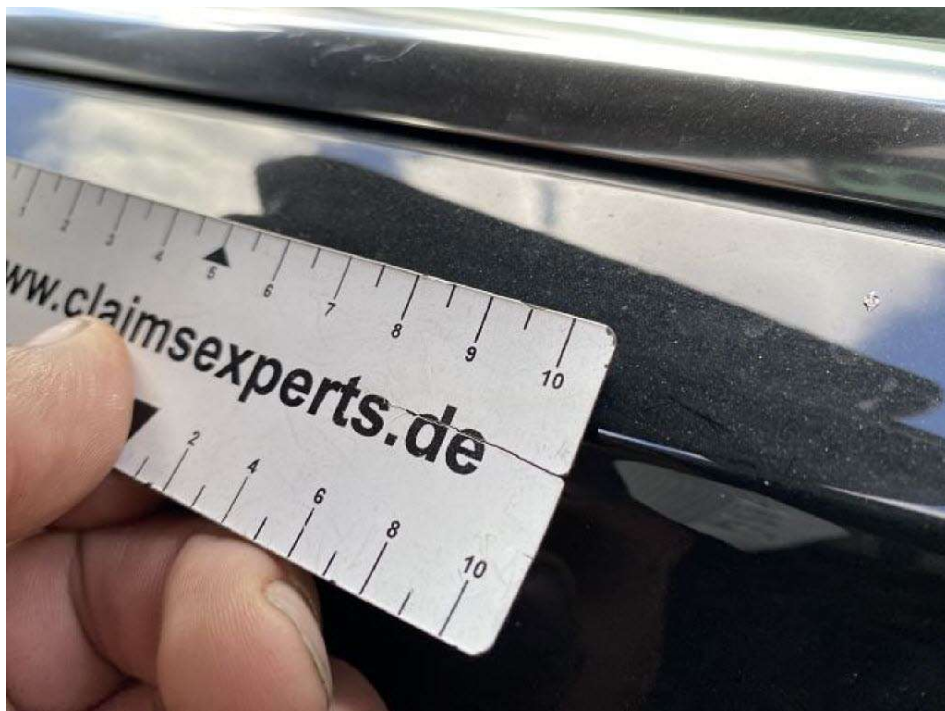
Bild 12 Detailansicht Tür vorne Fahrzeugseite links verschrammt
