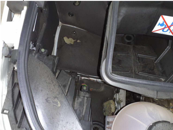
Beschädigung #7: Fahrerhaus: Dämmmatte - Marderschaden - erneuern
