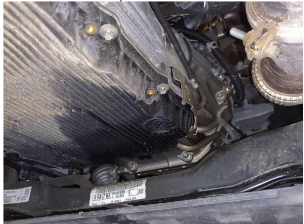
Beschädigung #8: Motor: Motor (Getriebe, Kostenausweitung möglich) - undicht - Diagnose durchführen
