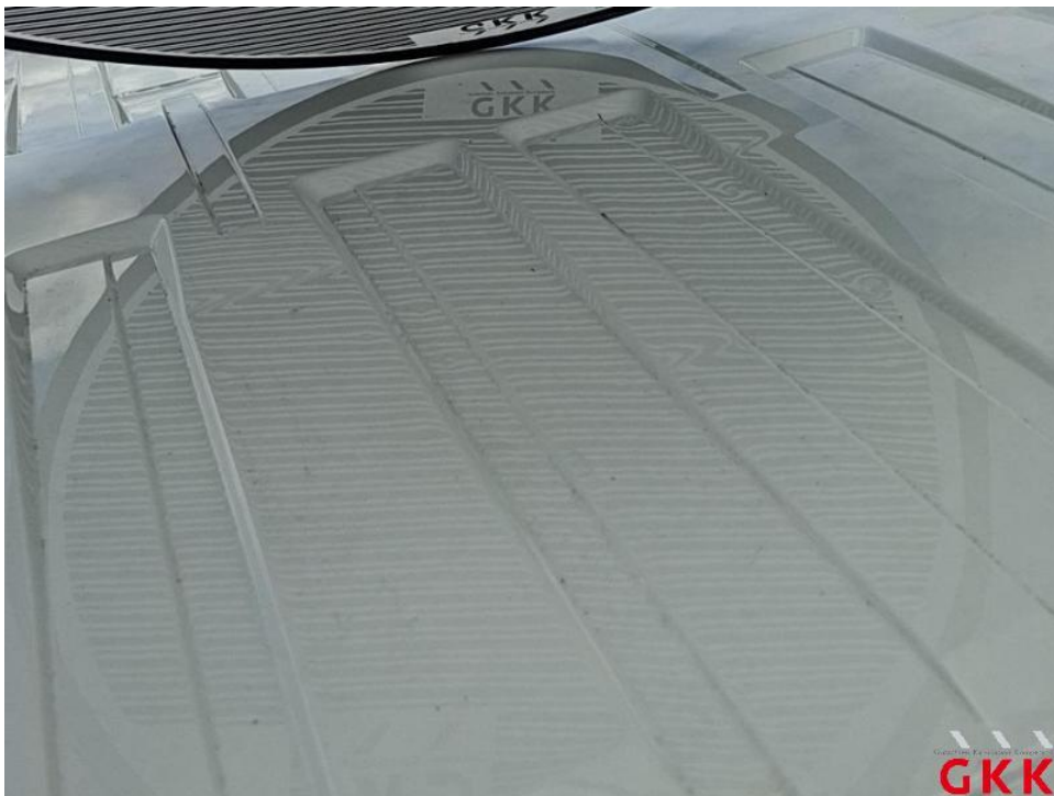
Bild 50. Dach, Hagelschaden, instand setzen
