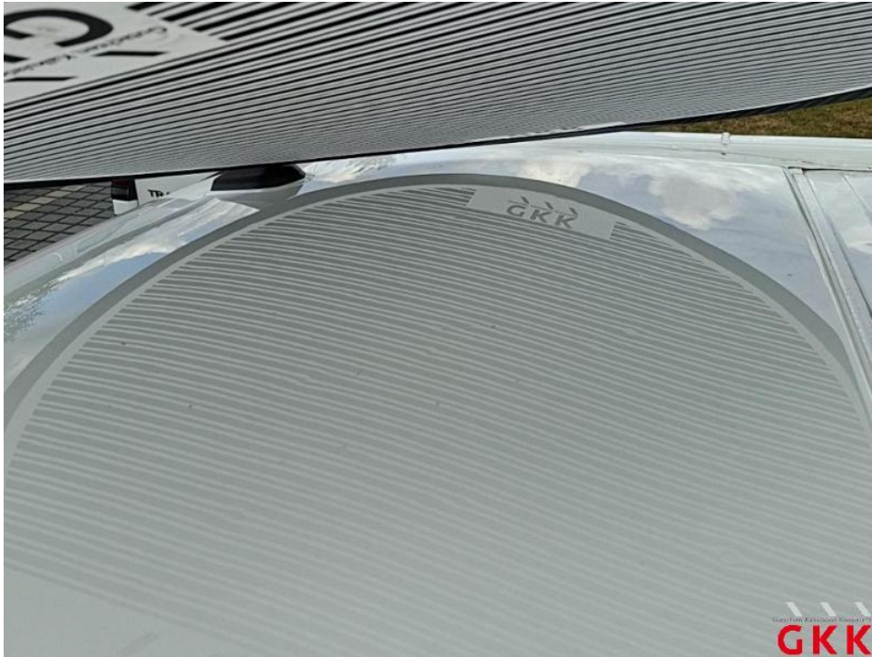
Bild 51. Dach, Hagelschaden, instand setzen
