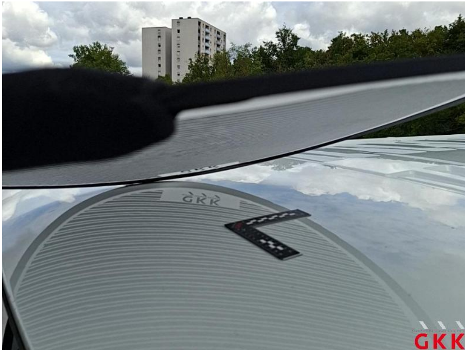
Bild 48. Dach, Hagelschaden, instand setzen
