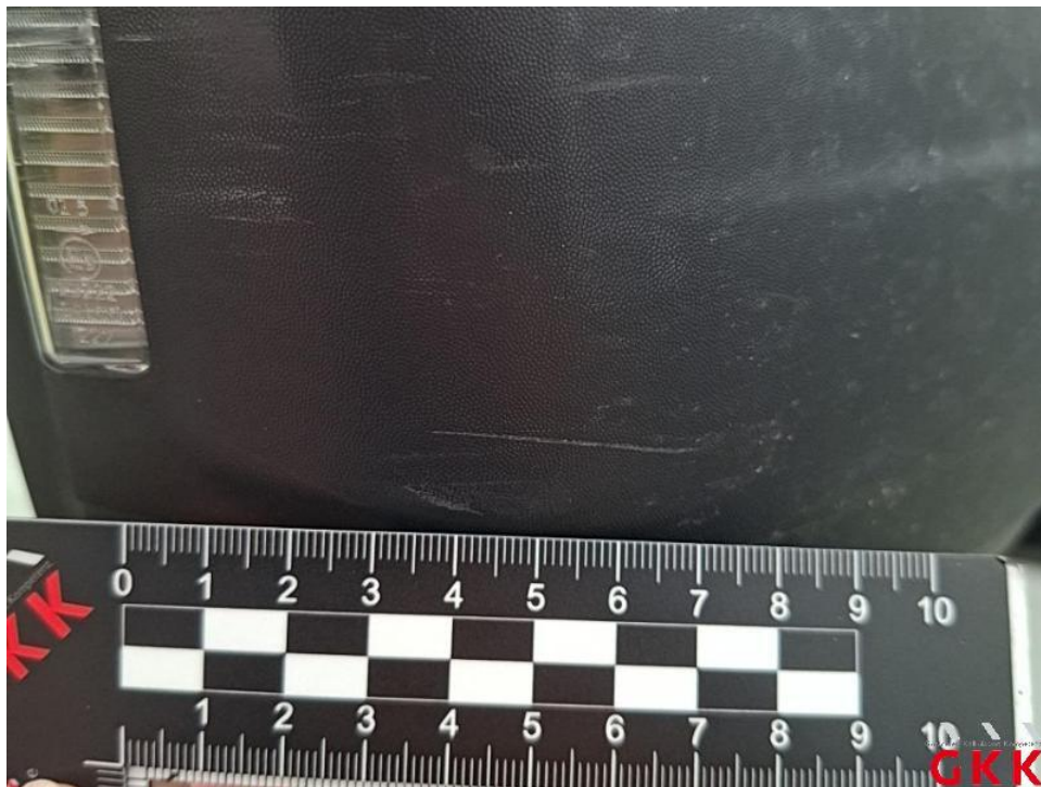
Bild 16. Spiegelgehäuse rechts, Kappe -unlackiert-, verkratzt, Smartrepair
