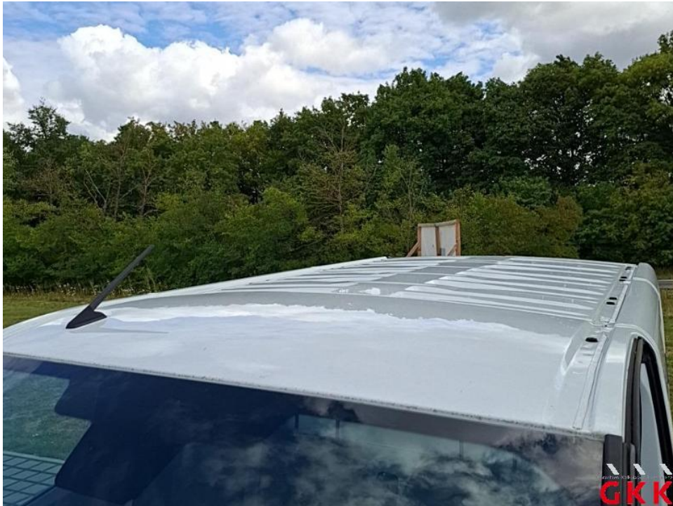
Bild 47. Dach, Hagelschaden, instand setzen
