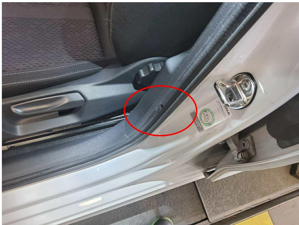
Bild 22 : Türdichtung vorne links, zerkratzt
