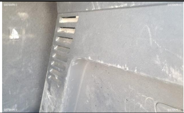
Foto daños internos 13
