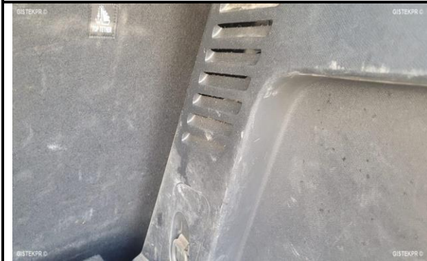
Foto daños internos 13
