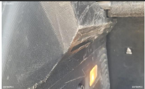
Foto daños internos 13
