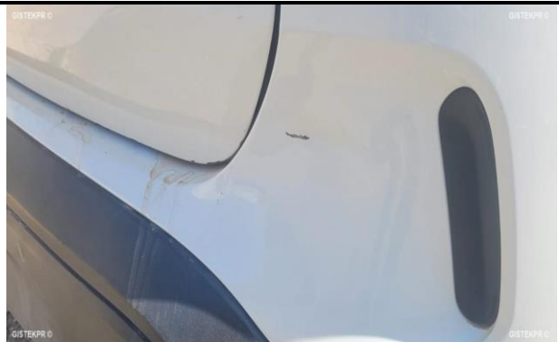
Foto daños externos 1
