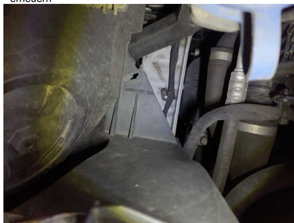
Beschädigung #13: Stossfänger vorn: Frontmodul - gebrochen / gerissen - erneuern
